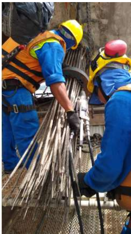
Figura 2.6 – Pesagem do cabo estai da ponte sobre o Rio Guamá.
