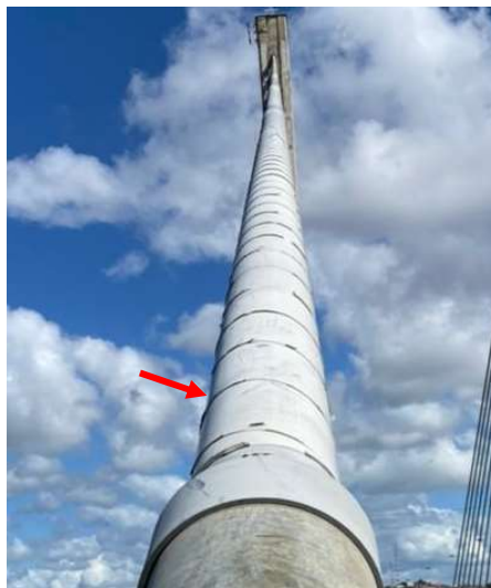
Figura 2.3 – Tubo em PEAD com cordões helicoidais-Ponte Aracaju-Barra dos Coqueiros
